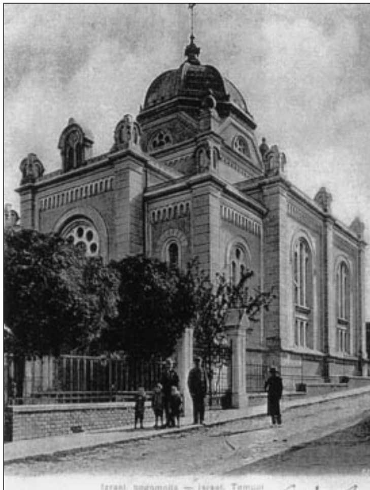
„Vukovarska Sinagoga, devastirana 1941, u potpunosti porušena 1958“
